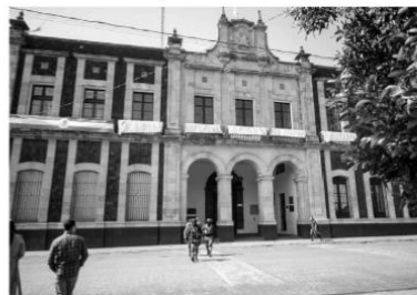
No se reportan afectaciones en edificios ni viviendas
