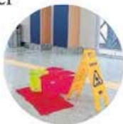
Goteras en el remodelado AICM
