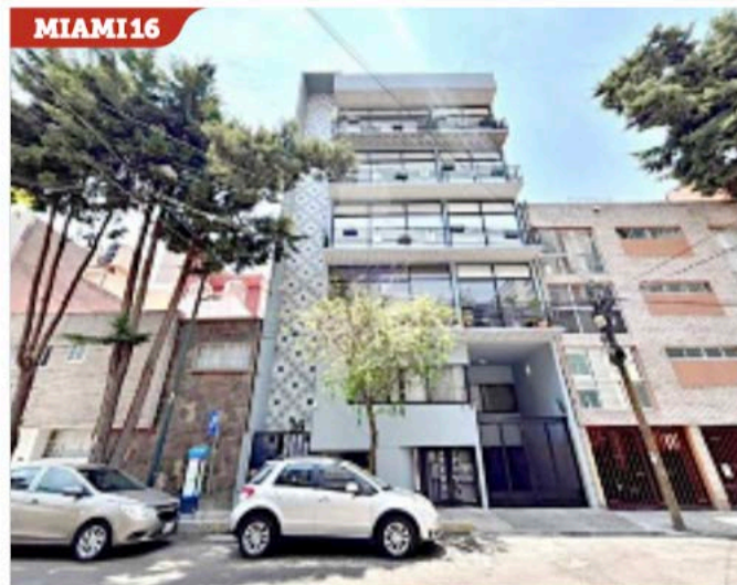
■ La primera propuesta busca intervenir el edificio a través de la reposición de tinacos, repellido y pintado.
