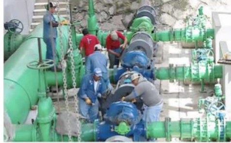
Las obras de reparación en Toluca terminaron y se rehabilitará el suministro de agua
