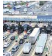
La obra abarcará el segmento Tepotzotlán-Jorobas.
