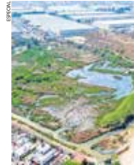
La presa se localiza en la colonia Ejidal San Isidro.
