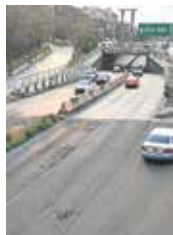
En la segunda semana de julio se comenzaron los trabajos.
