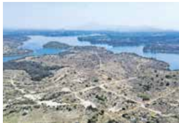
La obra busca abastecer de agua potable al Valle de México.
