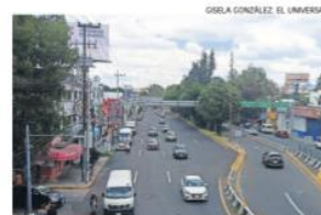
Los trabajos de repavimentación continúan en ambos sentidos de avenida Gustavo Baz.
