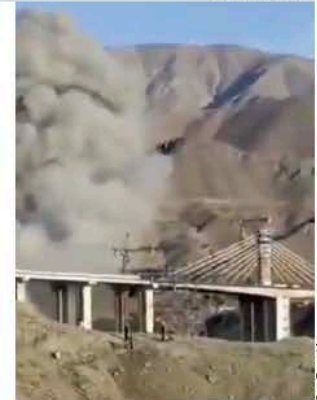
DERRUMBE del puente más alto de Irán.
