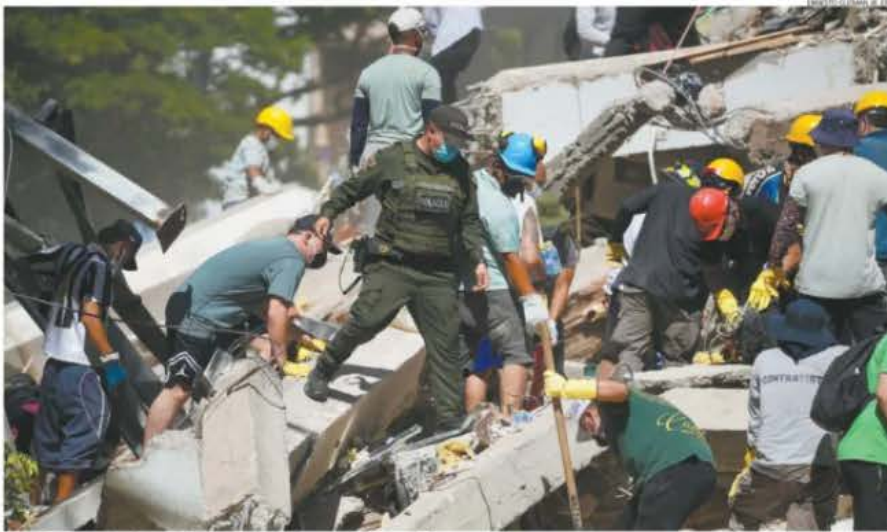
Voluntarios y rescatistas buscan sobrevivientes tras el colapso de un edificio en Cali.
