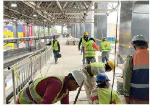
A MEDIAS. Oficialmente ayer inició operaciones la estación del Metro Chabacano de la L2, pero las obras continúan.
