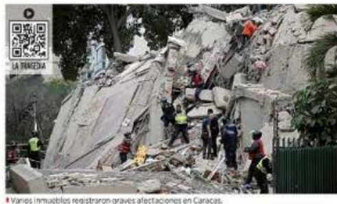
Varios inmuebles registraron graves afectaciones en Caracas.
